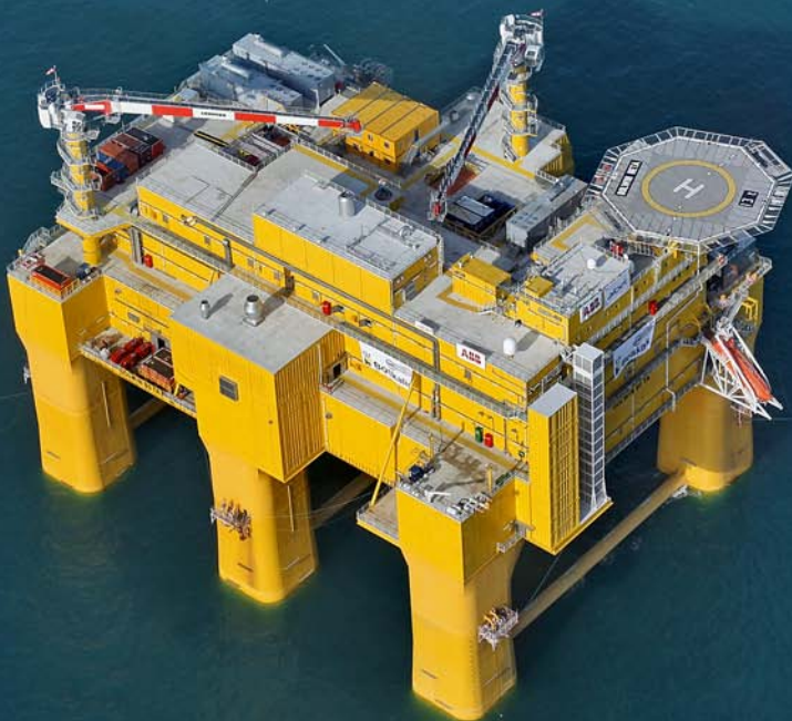
Transformatorstationen DolWin Beta i Nordsjön.
